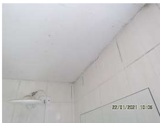
Pintura na área do box com manchas na pintura no teto
