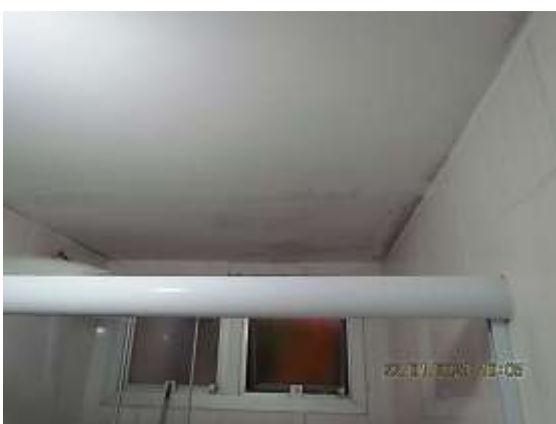
Pintura na área do box com manchas na pintura no teto
