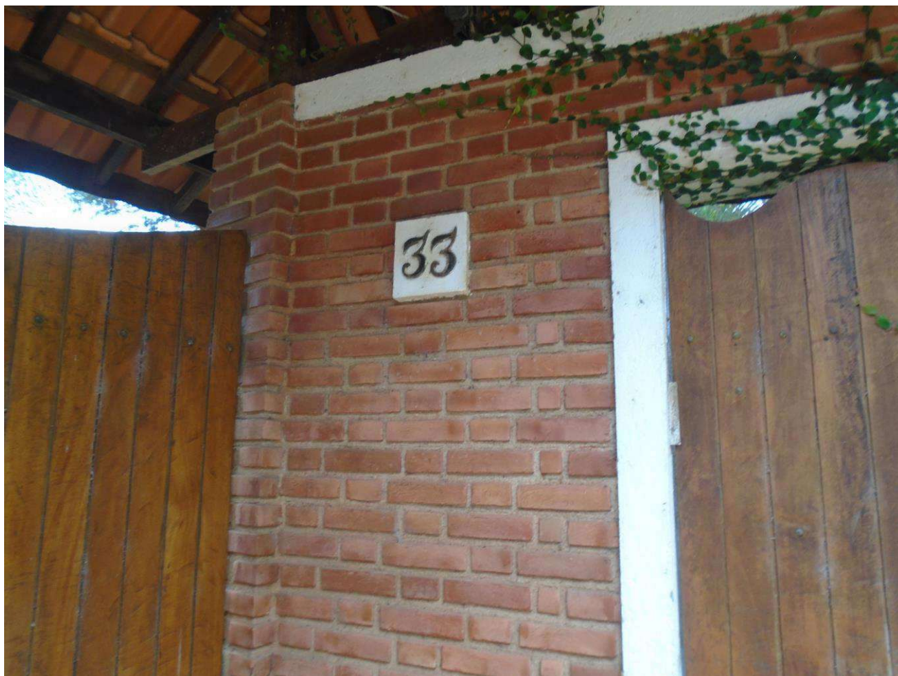
IMÓVEL LOCALIZADO NA RUA PARANÁ Nº. 33
