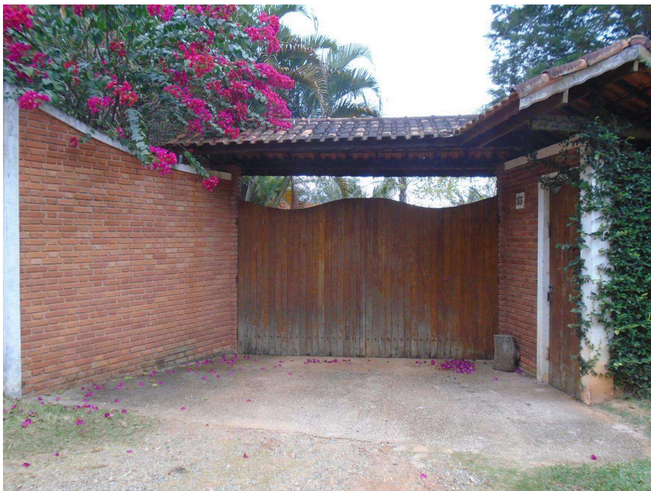
VISTA DO PORTÃO DE ENTRADA DO IMÓVEL.
