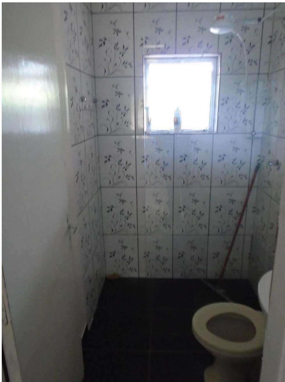
BANHEIRO DA RESIDÊNCIA DO CASEIRO.
