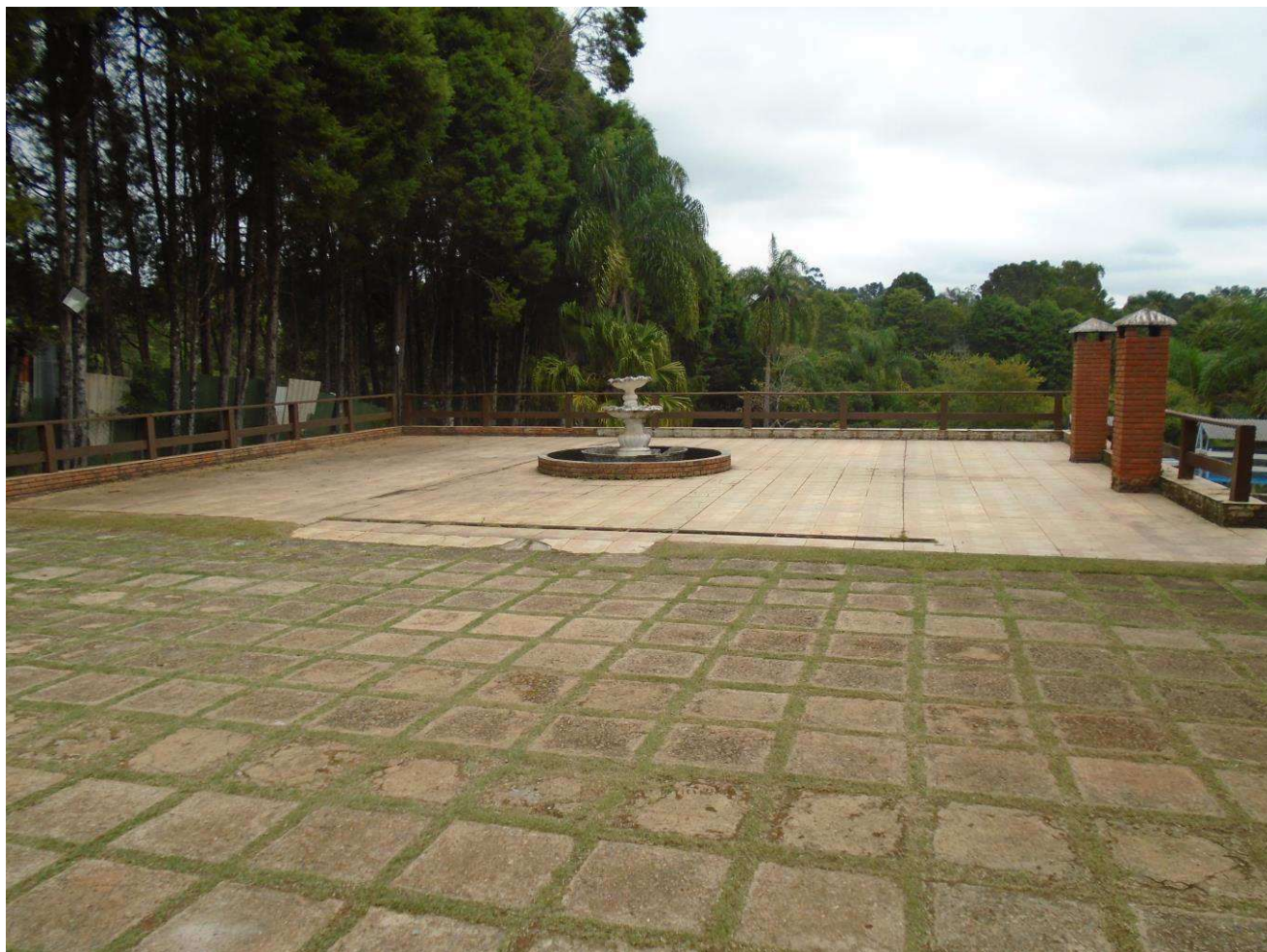
SOLÁRIO. COBERTURA DO SALÃO DE JOGOS.
