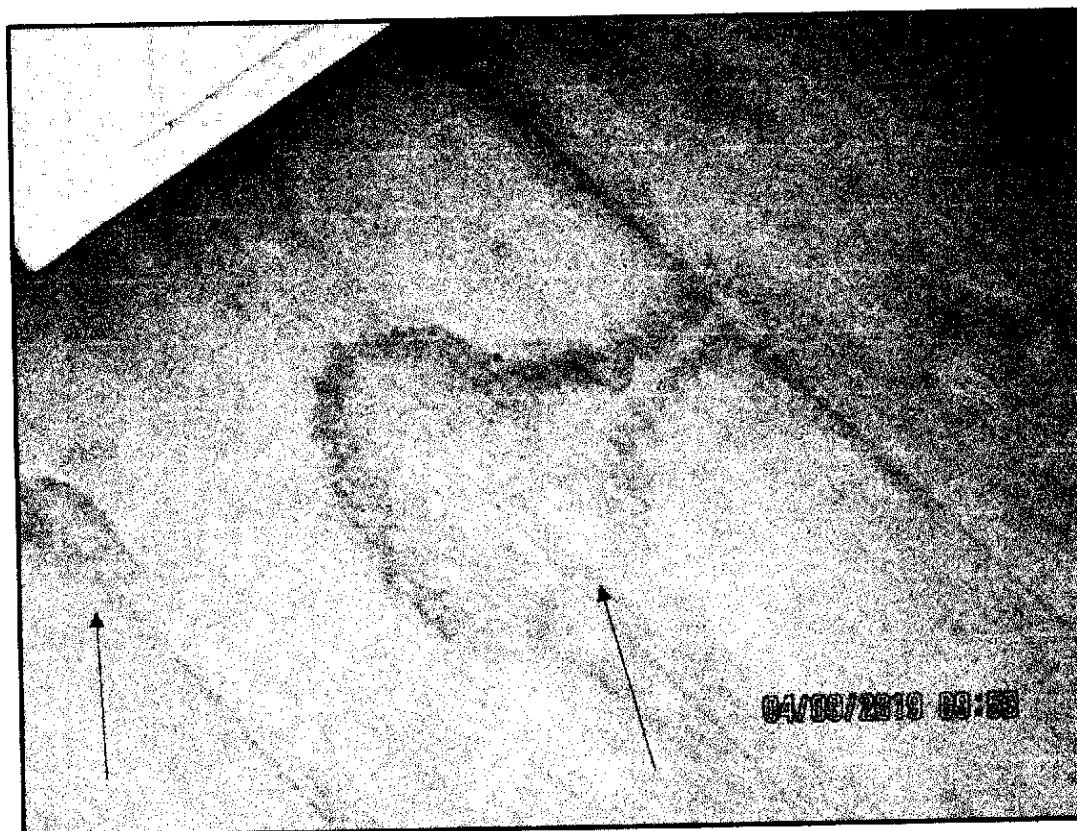
Detalhe de mancha de umidade no piso
