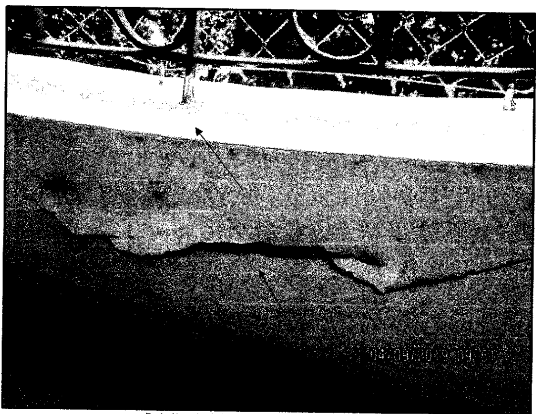
Detalhe de trinca e fissuras na alvenaria.
