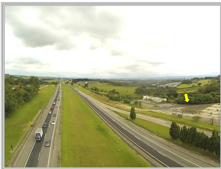
Foto nº 02 (📍): O acesso ao imóvel avaliado, indicado por seta, é praticado por uma pista marginal a Rodovia Presidente Castelo Branco (SP 280) no sentido interior/capital.
