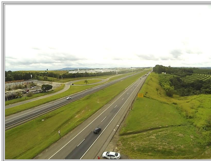
Foto nº 01 (📍): A Rodovia Presidente Castelo Branco (SP 280) é visualizada no sentido capital/interior e possui condições de tráfego rápido e seguro em suas duas pistas de rolagem.
