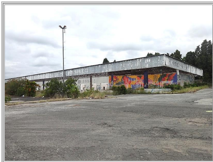
Foto nº 09 (↩): O conjunto do galpão, onde funcionava o restaurante, está evidentemente abandonado e mostra clara os sinais dessa situação.
