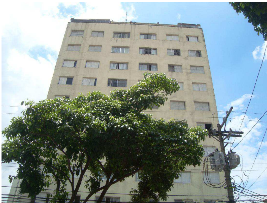
Foto nº 1- Vista parcial frontal do edifício
