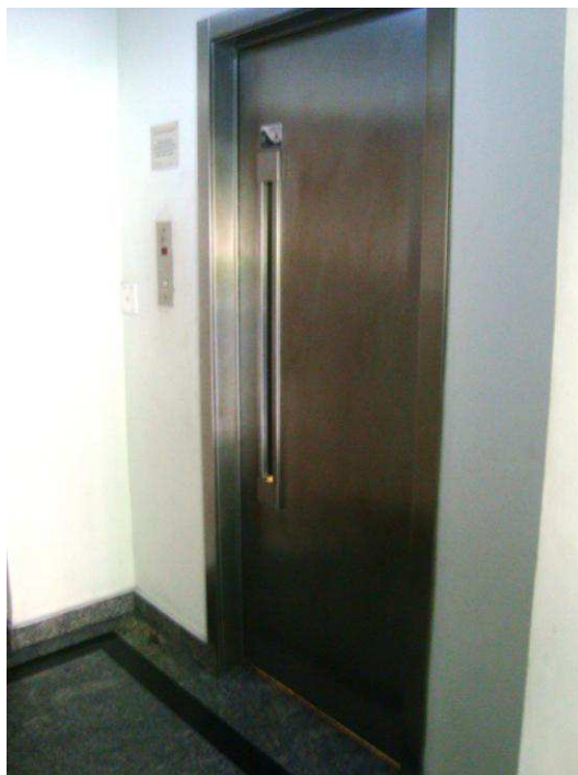
Foto nº 24- Vista parcial da porta externa do elevador
