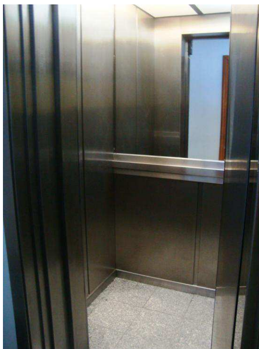
Foto nº 25- Vista parcial da parte interna do elevador
