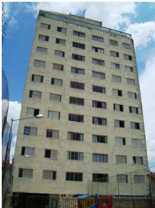
Foto nº 4- Vista parcial traseira do edifício
