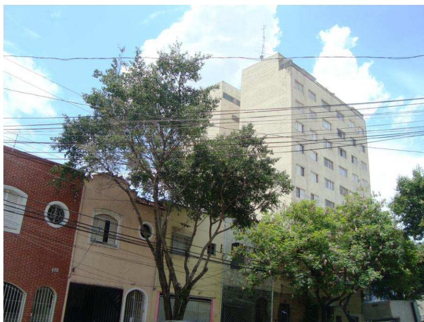
Foto nº 3- Vista parcial lateral do edifício
