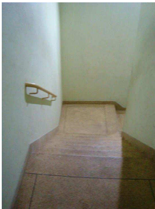
Foto nº 23- Vista parcial da escadaria de acesso aos pavimentos
