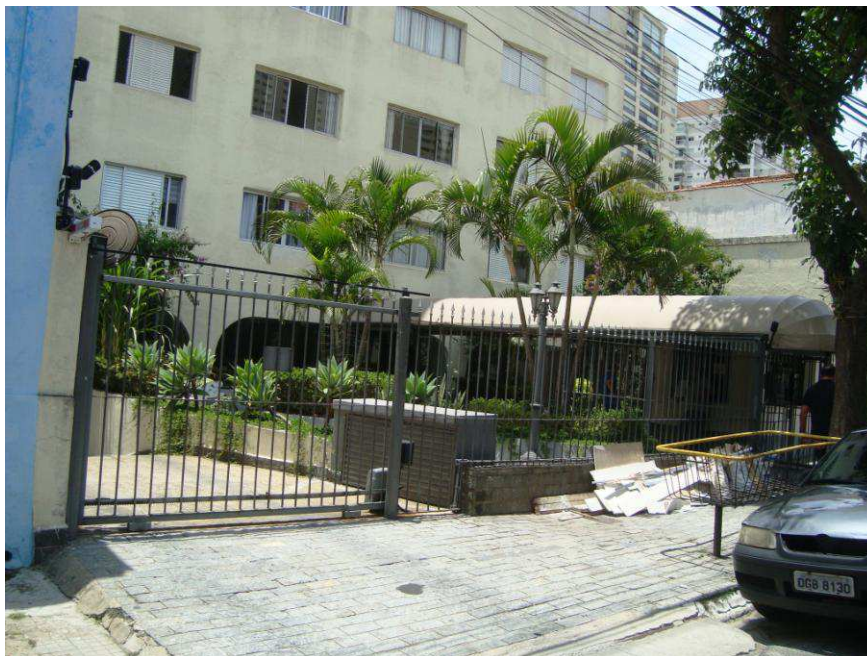
Foto nº 6- Vista parcial de um dos portões de entrada do estacionamento
