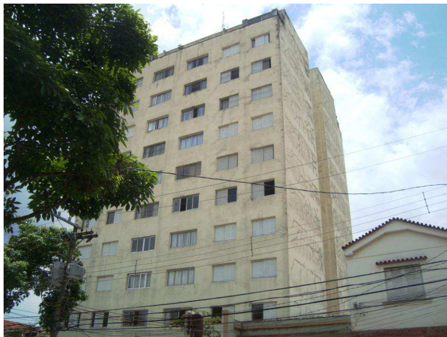
Foto nº 2- Vista parcial lateral do edifício
