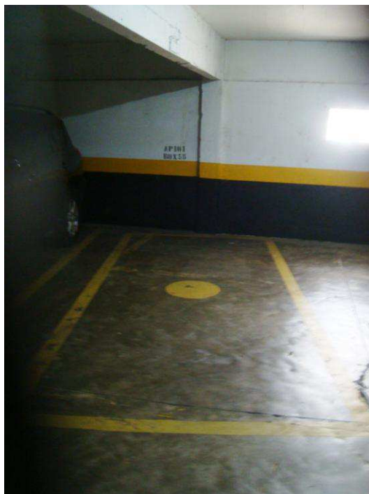
Foto nº 12- Vista parcial da vaga demarcada de estacionamento do imóvel em lide
