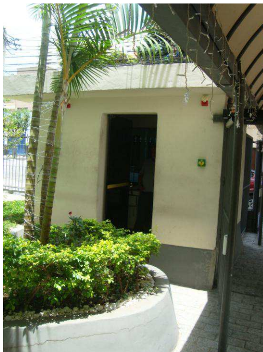
Foto nº 8- Vista parcial da guarita
