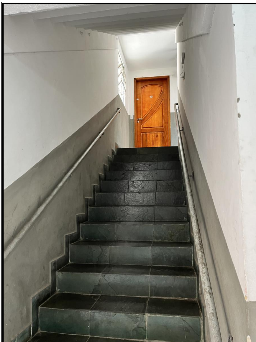
Foto – Vista das escadas que levam ao 3º andar do bloco C
