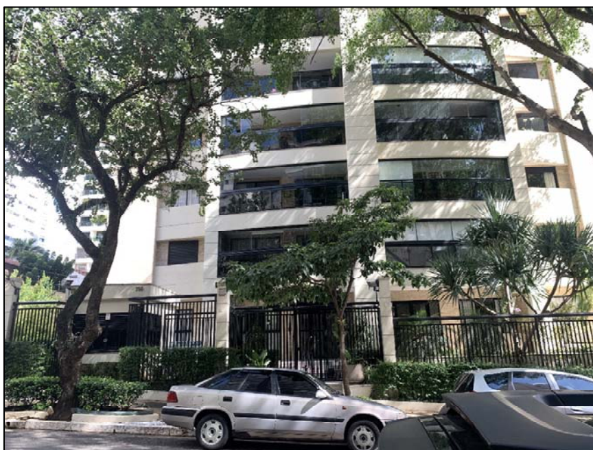
Foto 01. Fachada do condomínio do imóvel avaliando.
