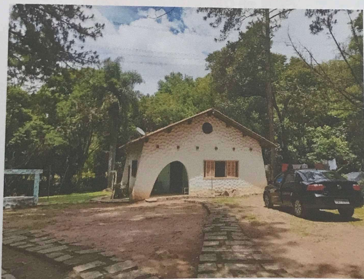
FOTO 9 – Vista da área interna do imóvel, objeto da presente Ação.
