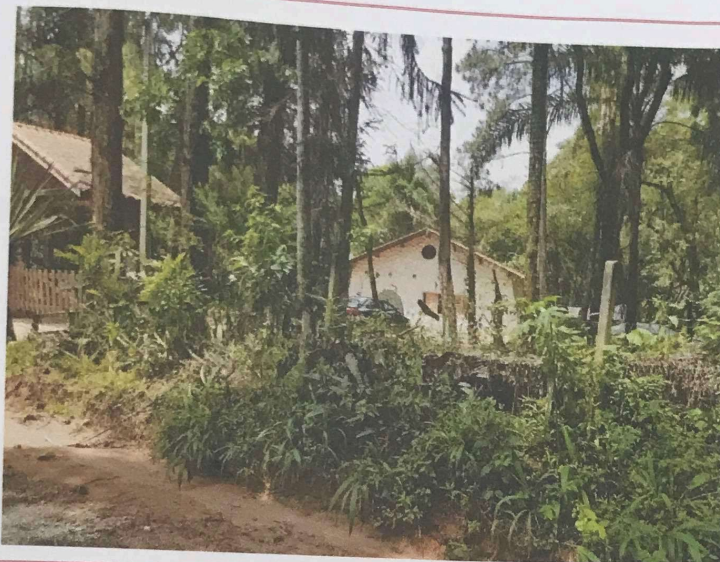
FOTO 8 – Vista da fachada do imóvel, objeto da presente Ação.
