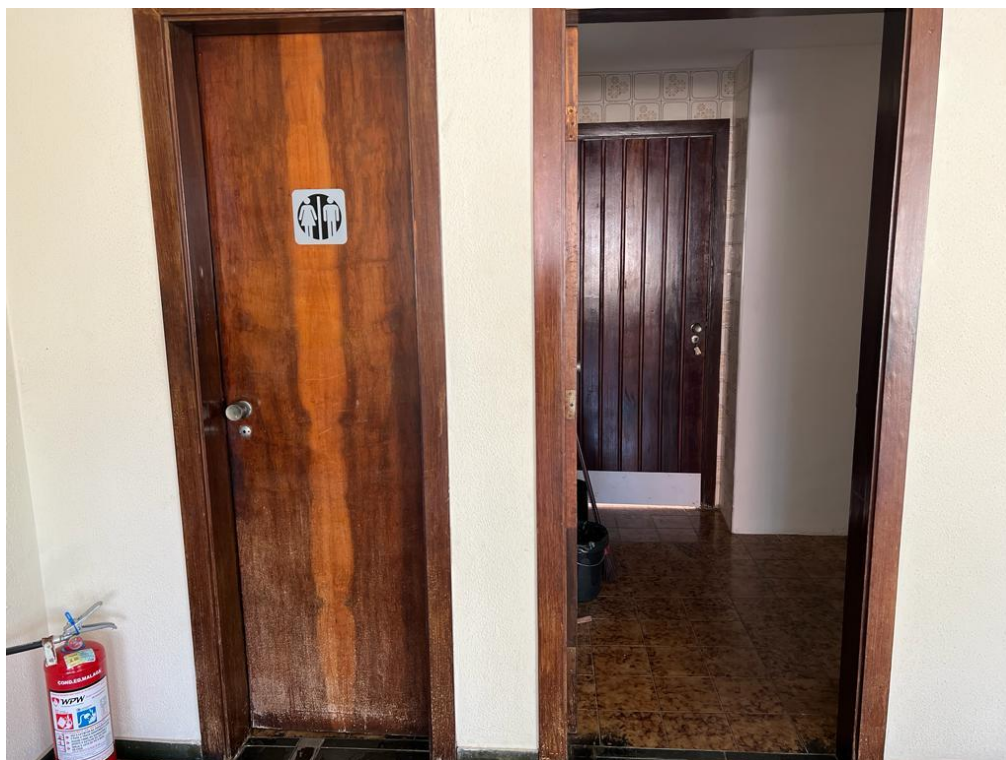
VISTA DO BANHEIRO DO SALÃO DE FESTA.
