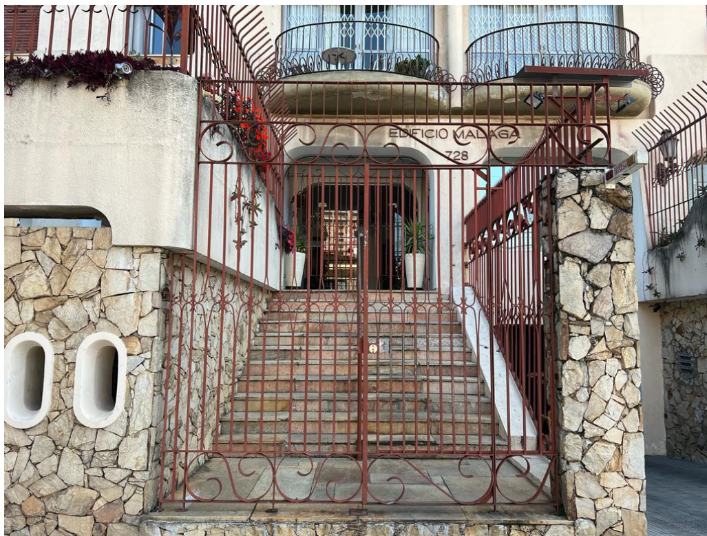
VISTA DA ENTRADA DO IMÓVEL.
