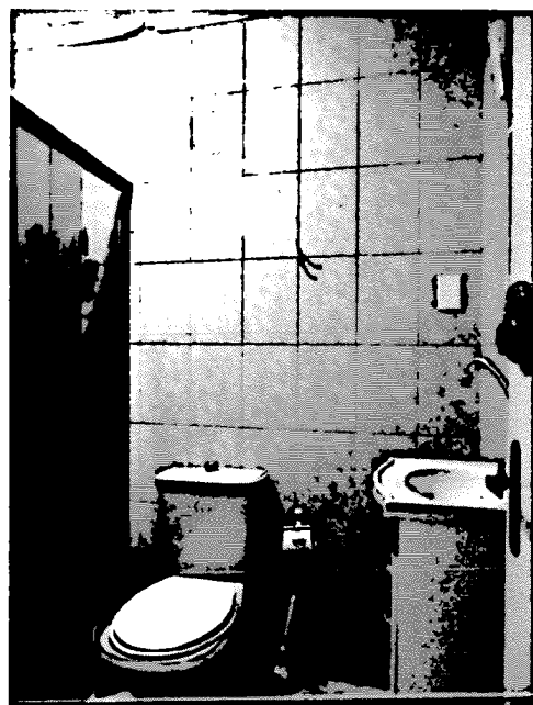
Banheiro Social (piso térreo, ex edícula)
