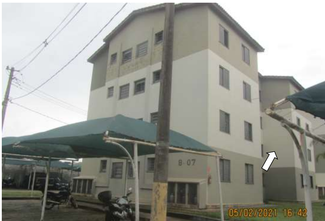
Foto 04> Detalhe do Bloco 07, destacando a posição do apartamento no bloco.
