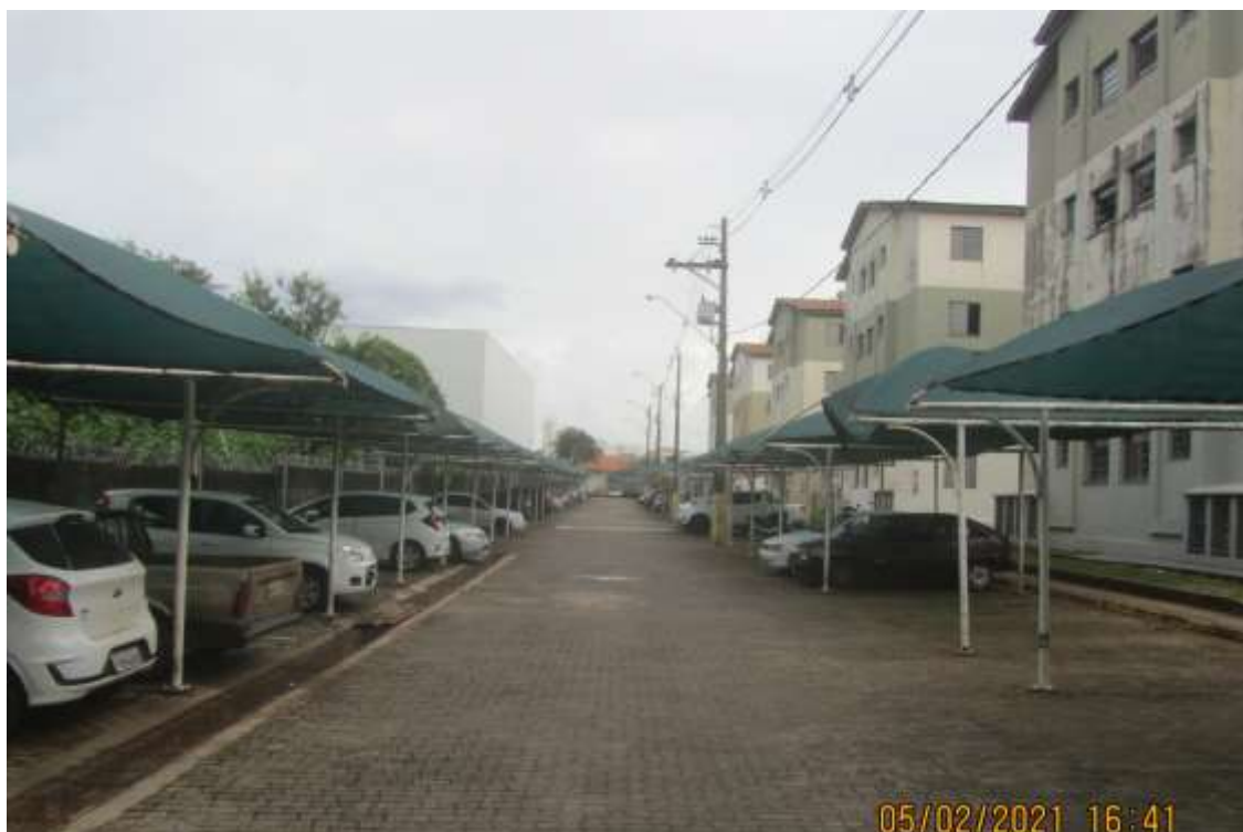
Foto 03> Detalhe via de circulação comum do empreendimento, notando vagas de veículos
