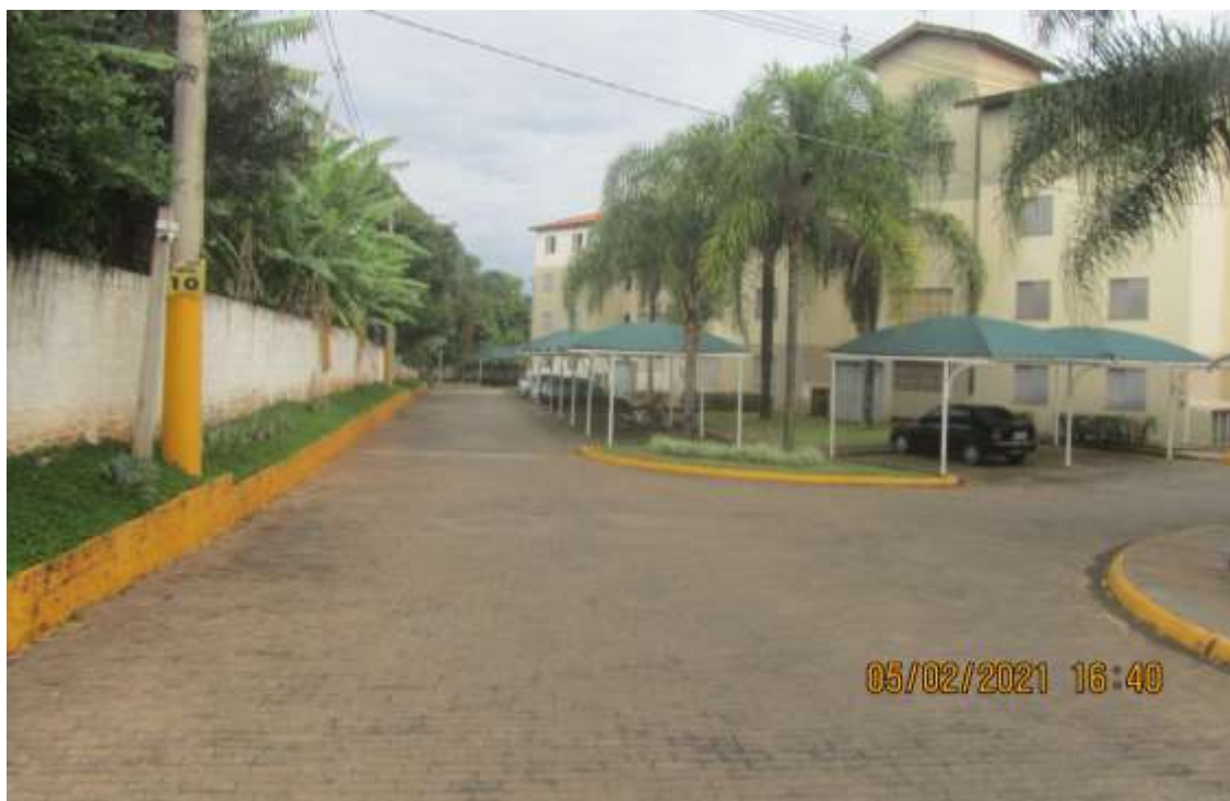
Foto 02> Detalhe via de circulação comum do empreendimento, notando vagas de veículos.
