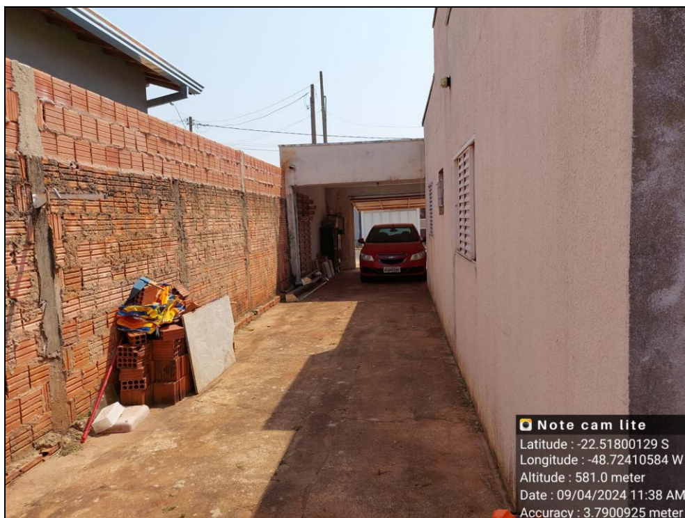
FOTO Nº 09:- Detalhe do corredor externo onde aos fundos vemos a cobertura destinada a garagem de veículos.
