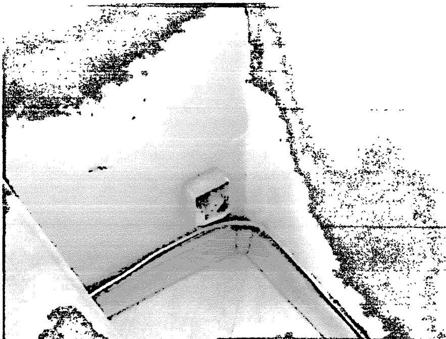
Aspectos rodapés e pintura geral – danificados
