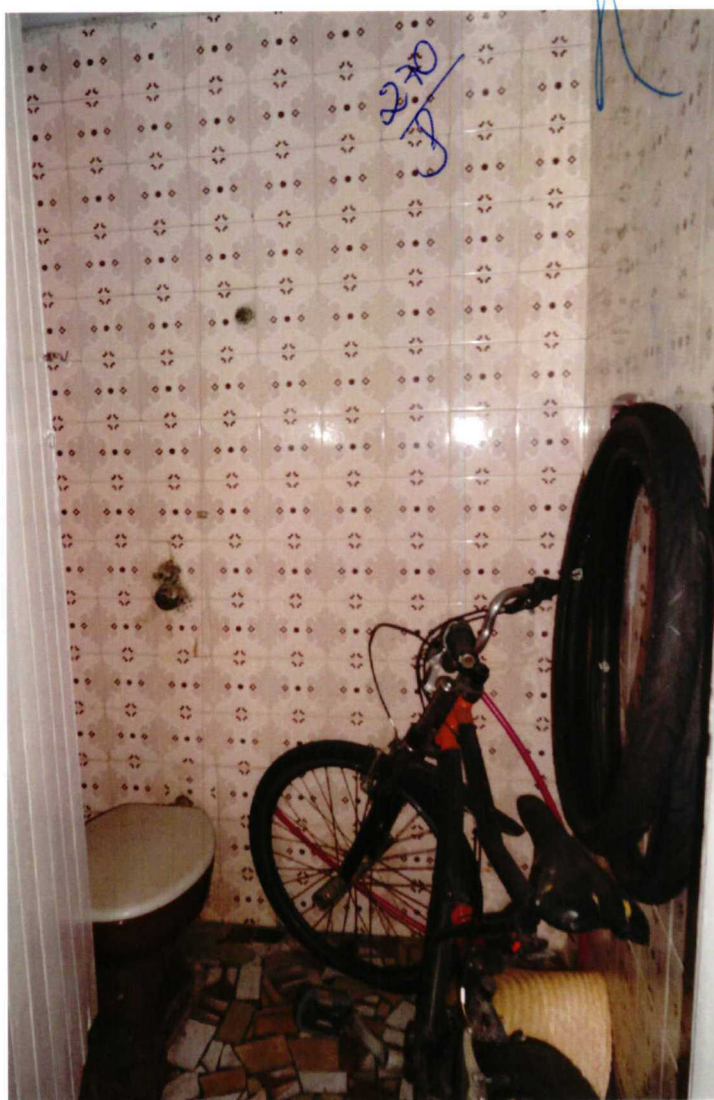
VISTA DO BANHEIRO II.
