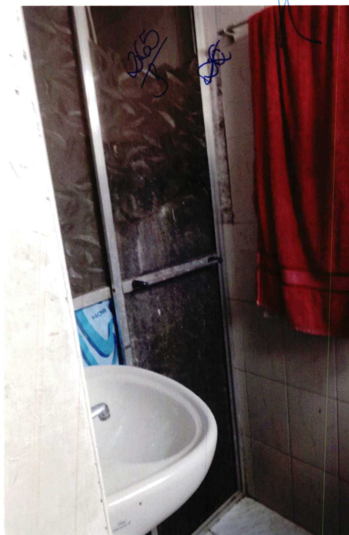
VISTA DO BANHEIRO I.
