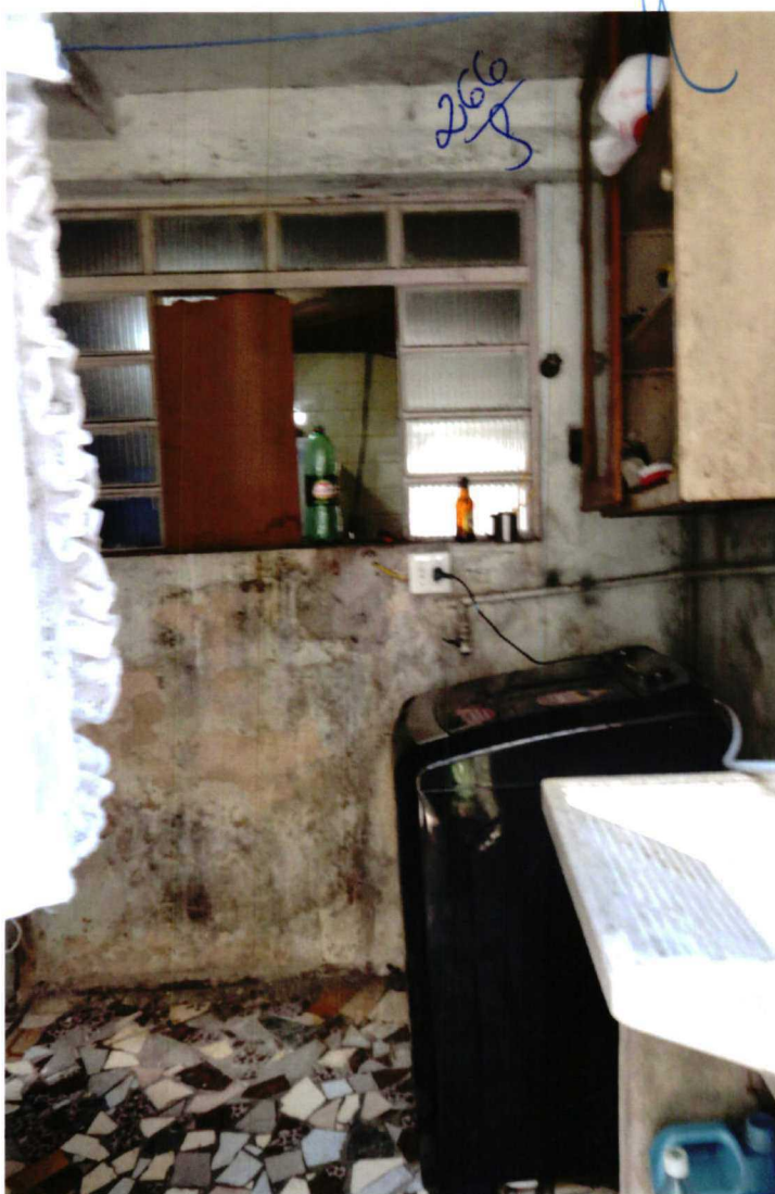
VISTA DA ÁREA DE SERVIÇOS.
