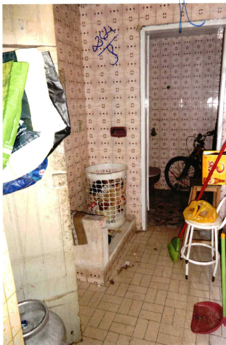
VISTA DO "HALL" INTERNO.
