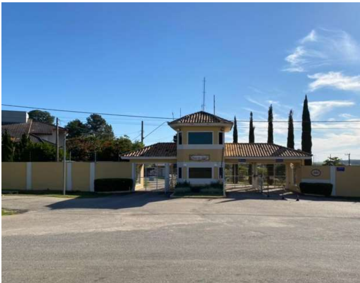
FOTO 01: FACHADA DO CONDOMÍNIO
