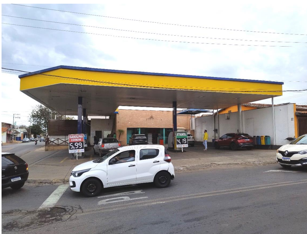
Foto 04 – Outra vista da fachada do imóvel avaliando
