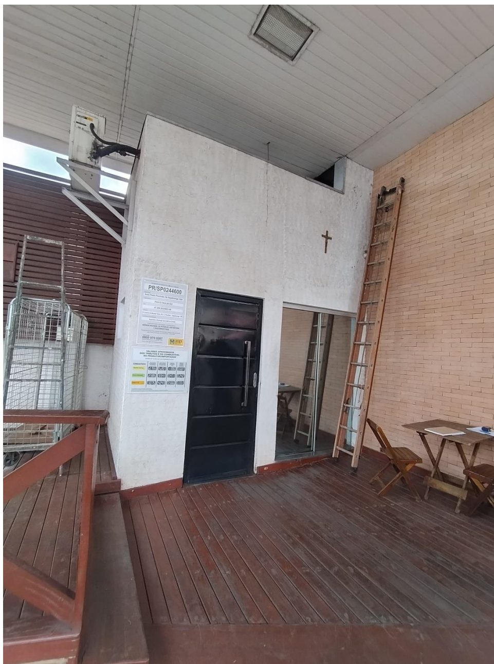
Foto 13 – Vista externa do escritório e banheiro
