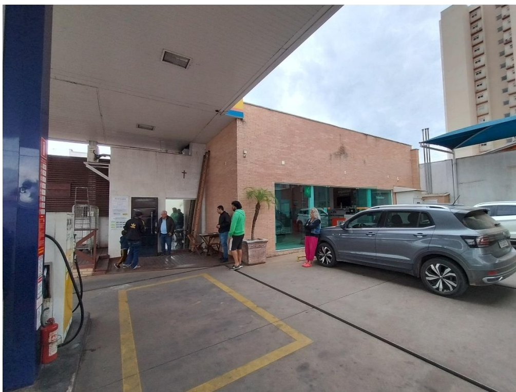
Foto 09– Vista geral da construção
