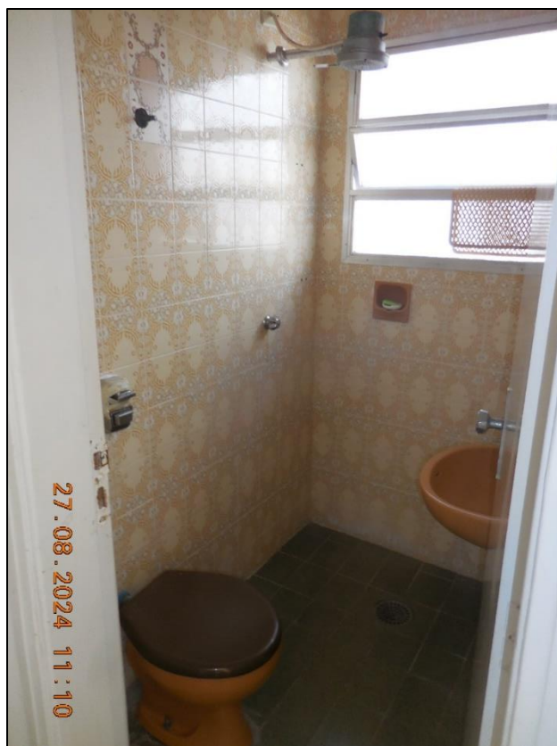
FOTOGRAFIA Nº 20: Vista geral do banheiro (área externa).
