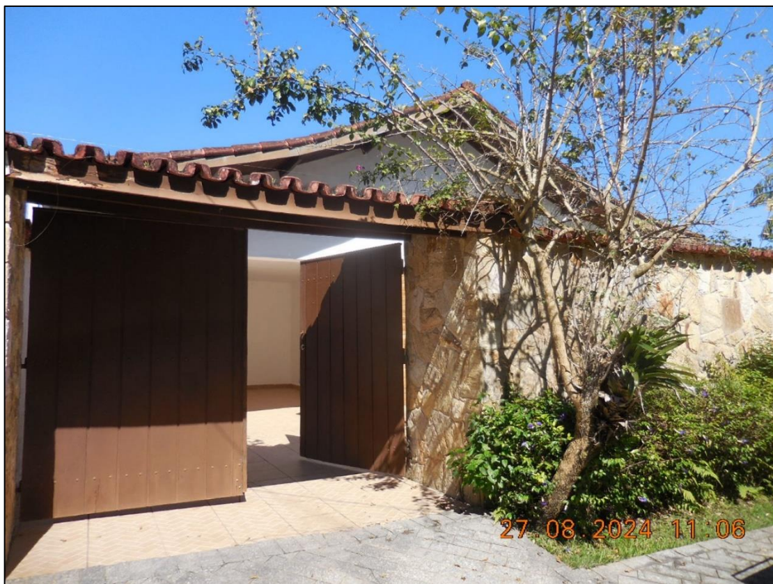
FOTOGRAFIA Nº 04: Vista geral do acesso às vagas de garagem.
