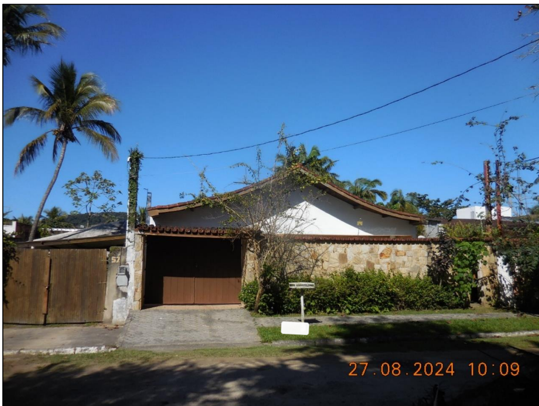
FOTOGRAFIA Nº 02: Vista da fachada frontal da edificação.
