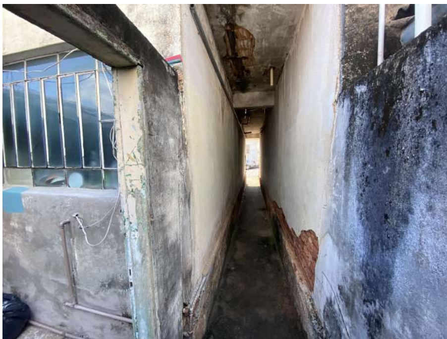
VISTA DO CORREDOR DE ACESSO A CASA Nº 470 HC01.
