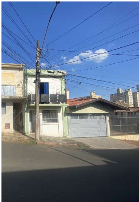
VISTA DA ENTRADA DO IMÓVEL - CASA Nº 470 HC01.
