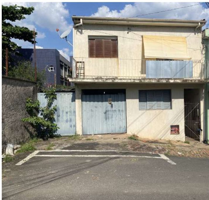
VISTA DA FACHADA DO IMÓVEL CASA Nº 470.
