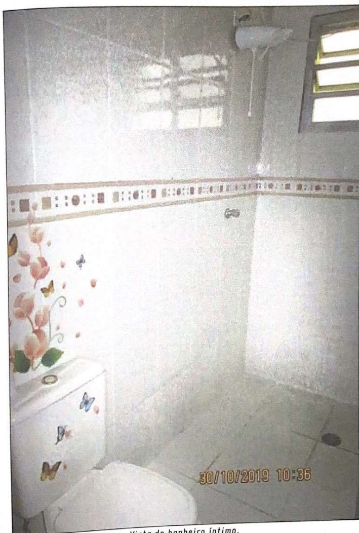
Vista do banheiro íntimo.
