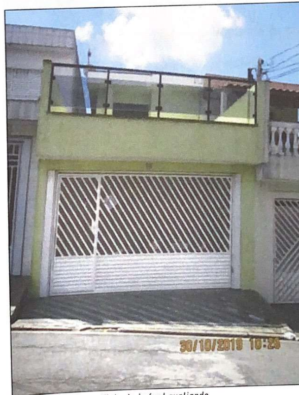
Vista do imóvel avaliando.
