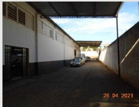
Vista dos fundos
