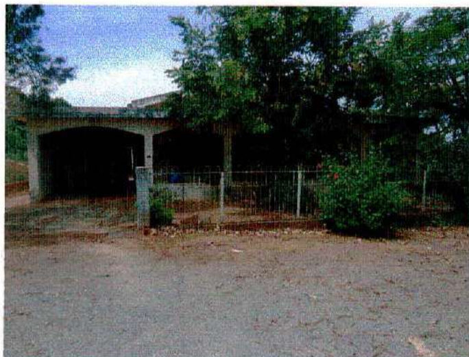
Vista da casa sede da propriedade item 4.1.1.
