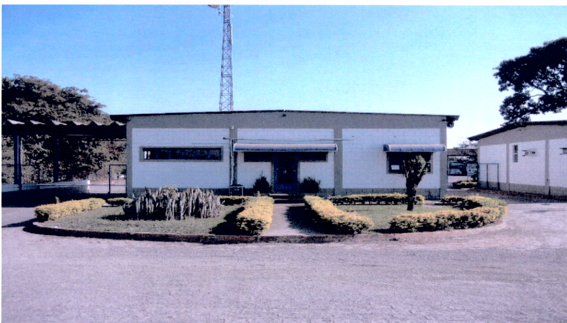
Foto 3. Escritório do local avaliado
