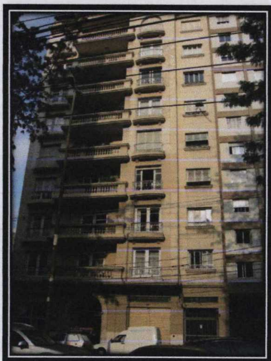
Foto n.º 04 – Idem, prédio situado à Rua Treze de Maio, 1.429 – Paraíso, São Paulo.
