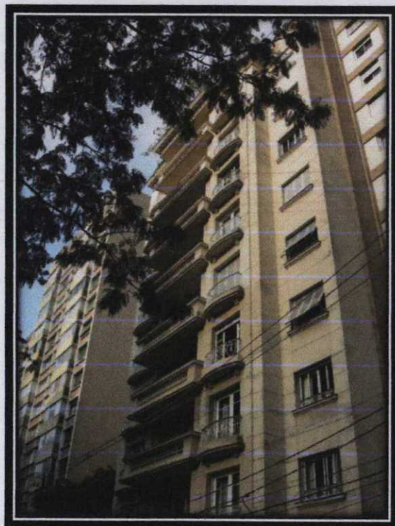
Foto n.º 03 - Idem, aspectos da fachada.
