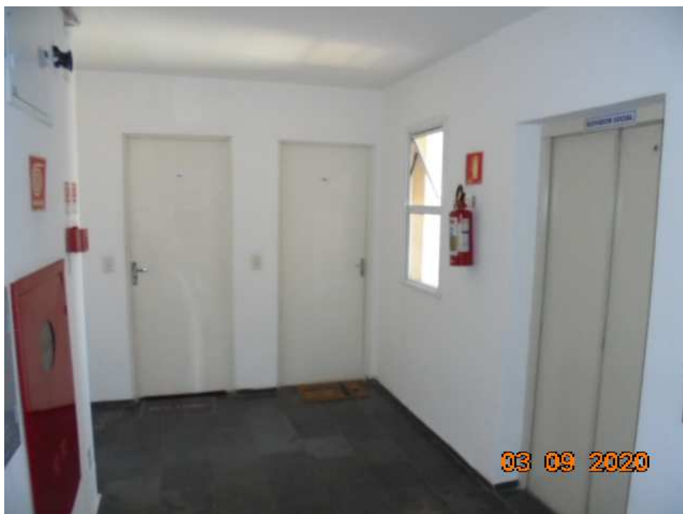
FOTO Nr.07: Vista do hall interno e porta de acesso ao apartamento avaliando.
