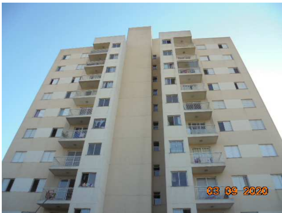
FOTO Nr.05: Detalhe da fachada de fundos do edifício onde se situa o apartamento avaliando.
